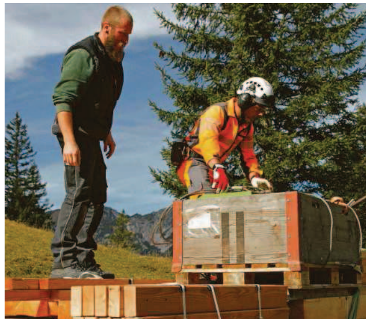
Der Holz- und Materialtransport ab Valorschstrasse zur Baustelle muss gut organisiert sein.
