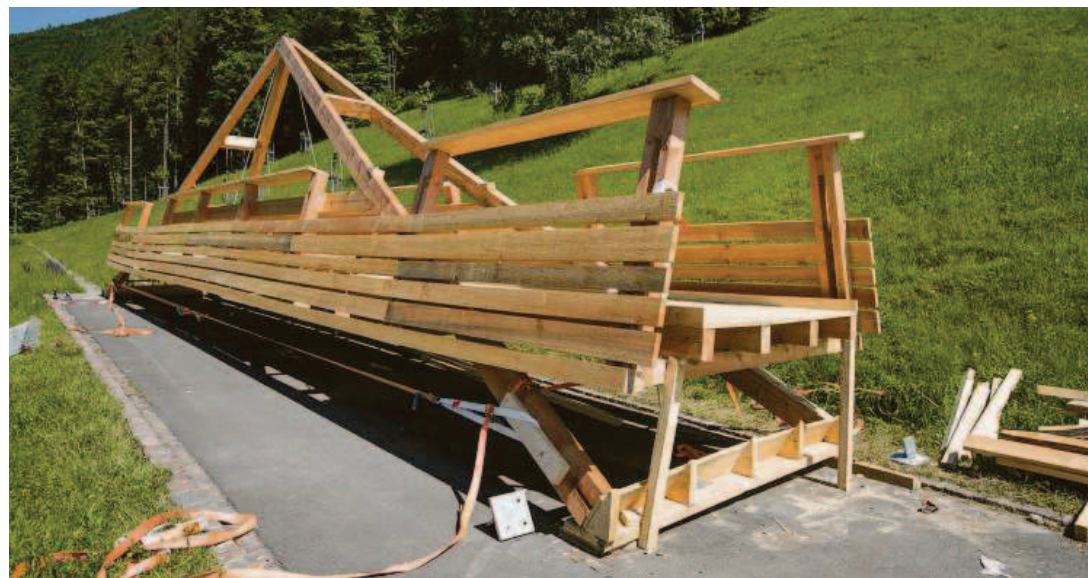
Die Holzbrücke wurde per Helikopter zum «Tüfloch» transportiert.
